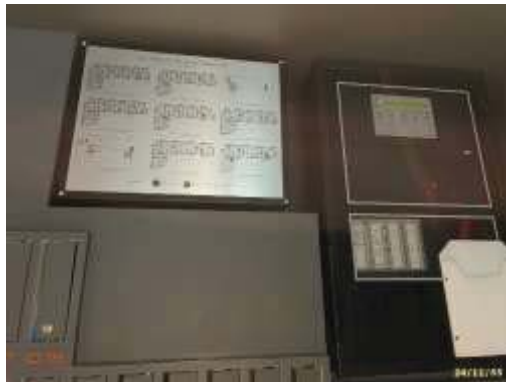
แผงควบคุมระบบแจ้งเหตุอัคคีภัย (Fire Alarm Control Panel ; FCP)
