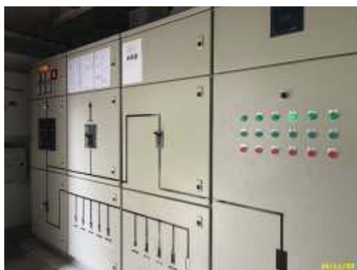
แผงจ่ายไฟหลัก (Main Distribution Board, MDB)
