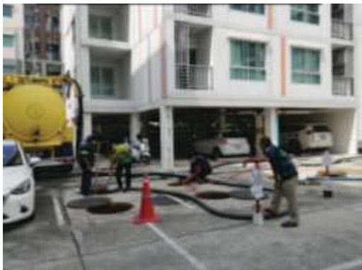
สูบลูกอม และกากไขมันระบบบำบัดน้ำเสีย (12/10/65)
