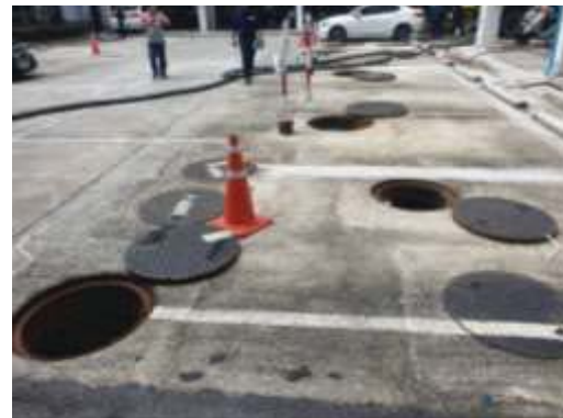
สูบลูกอม และกากไขมันระบบบำบัดน้ำเสีย (12/10/65)
