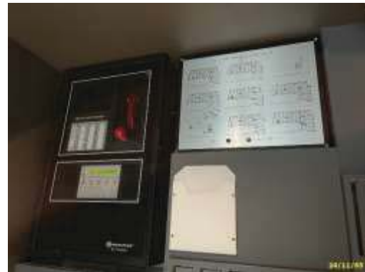
แผงควบคุมระบบแจ้งเหตุอัคคีภัย (Fire Alarm Control Panel ; FCP)
